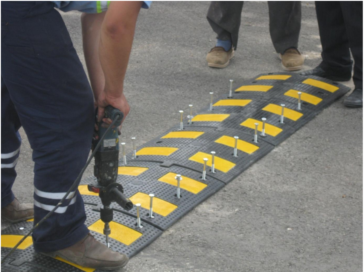
Mehmet Akif Caddesi 8. Boru İlköğretim Okul Önü Kasis Montajı
