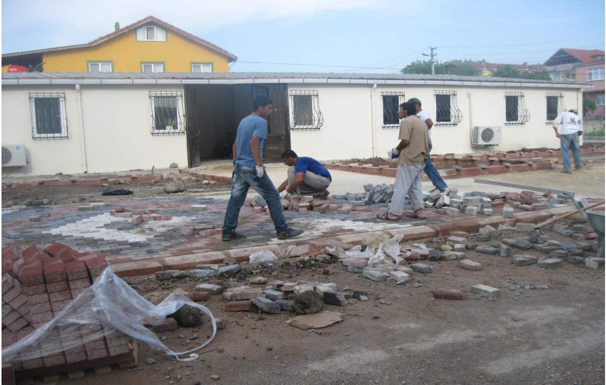
Barbaros Mah.27.sokak ile Pınar Cad arası (Kaymakamlık Arkası Yolda Prefabrik bina önü) kaldırım çalışması
