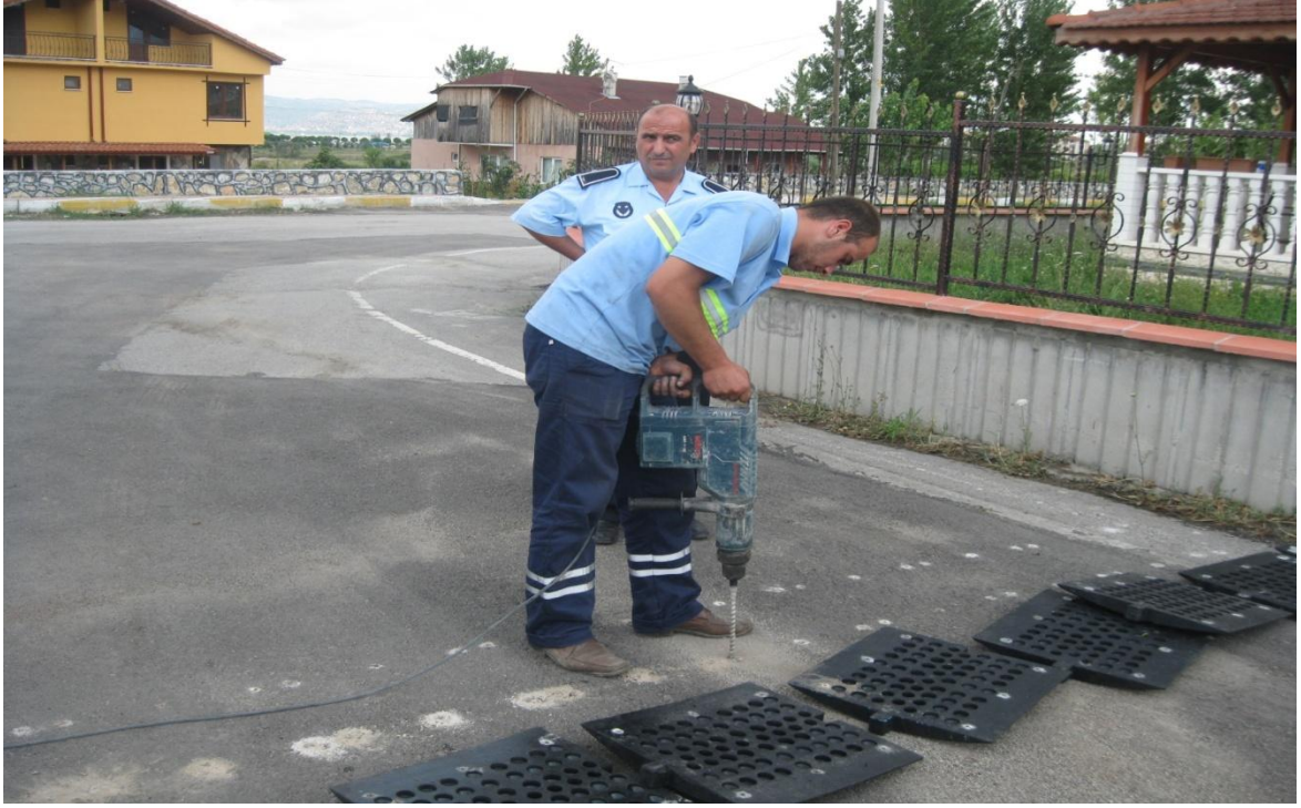
Çeşitli Cadde ve Sokaklara Hız Kesici Kasislerin Montajı yapıldı.
