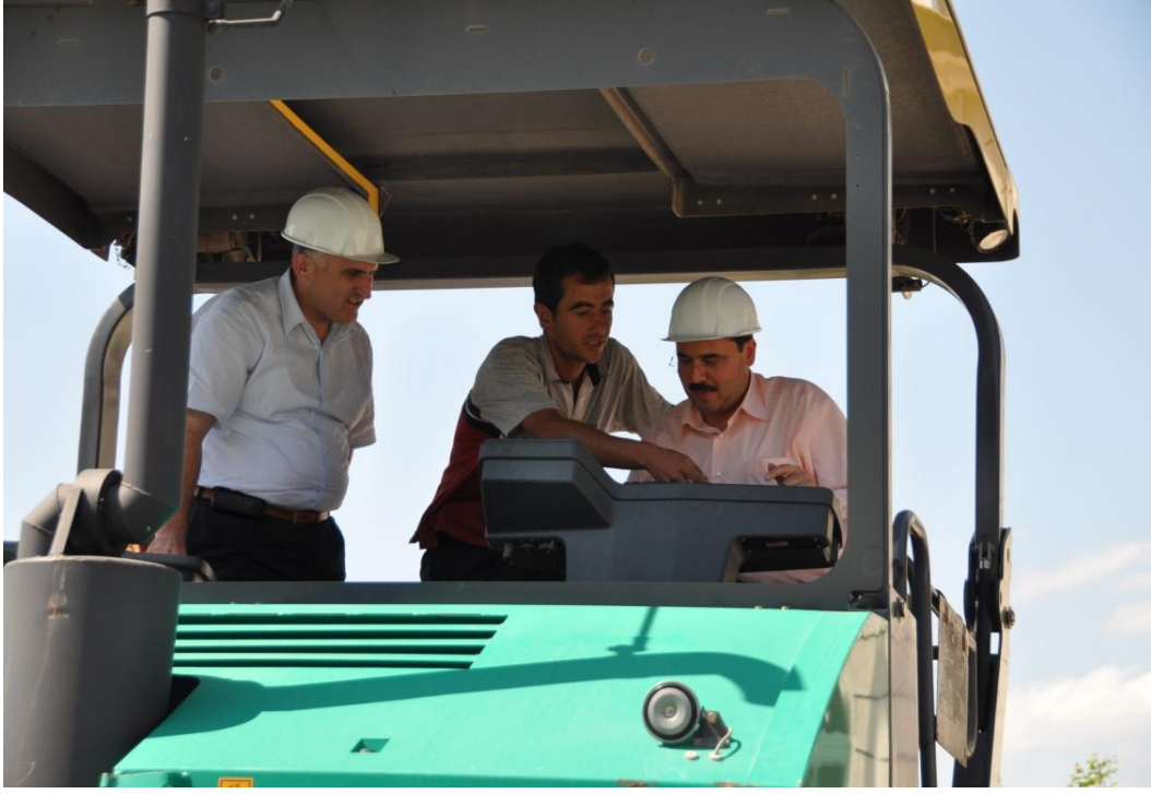
Abdlmecit Caddesi Asfalt alıřması
