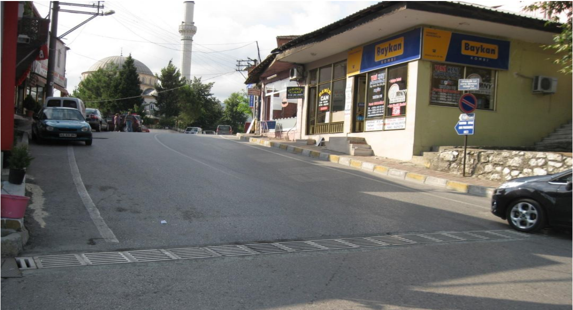
Barbaros Mahallesi Fatih Caddesi yağmur Suyu ve Izgaraları yapıldı.
