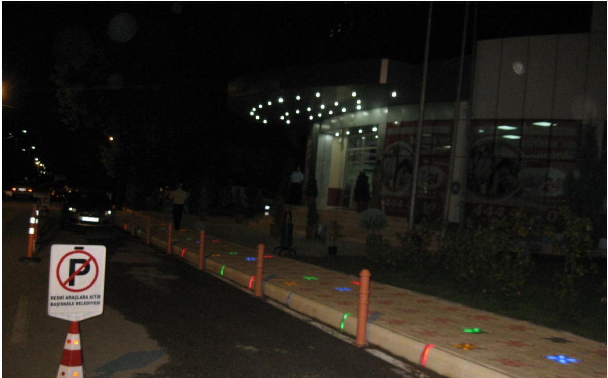
Belediye Hizmet Binası Önü Bordür Çalışması
