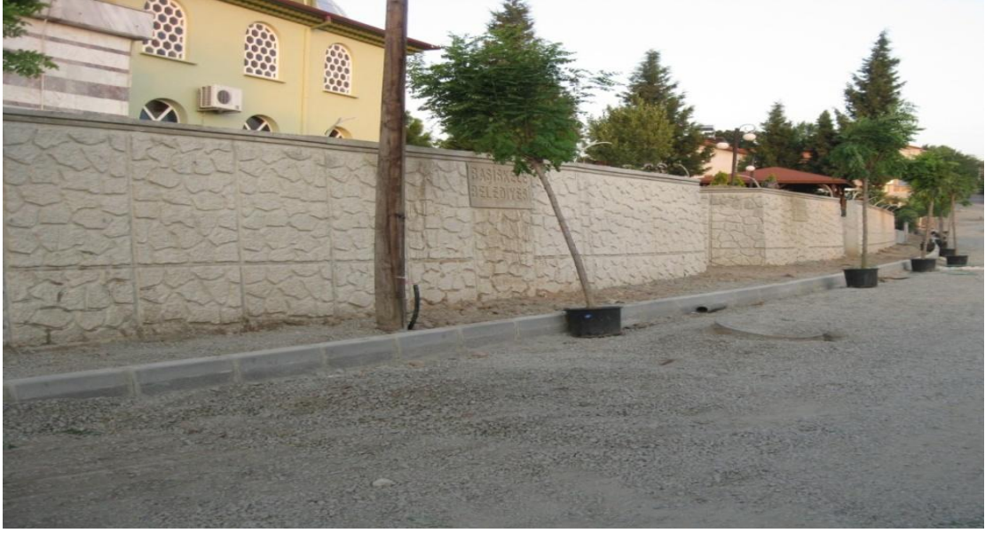
Mevlana Cami Duvarı Perde Beton Yapım İş
